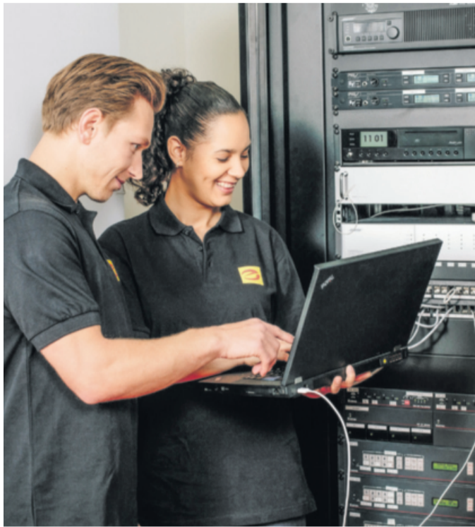
Nicht nur die Arbeit am Sicherungskasten gehört zur Ausbildung – sondern auch die am Serverschrank.
