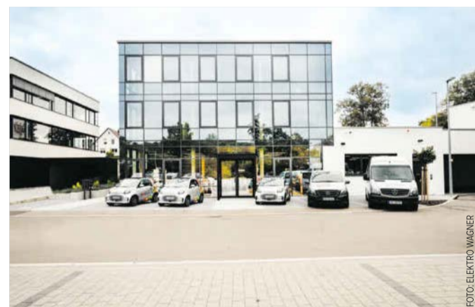
Seit Juli 2021 berät das Team von Elektro Wagner Kunden am modernen Standort in der Stuttgarter Straße in Uhingen.
